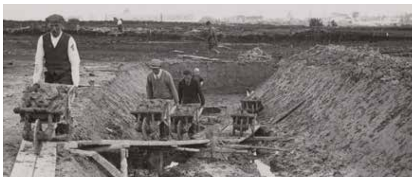
^ de aanleg van de Bosbaan
